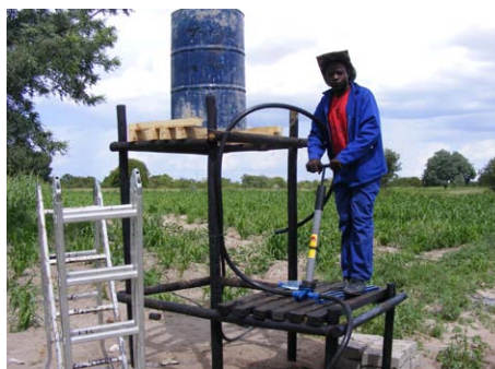
Pumpenanlage in Epyeshona (Nordnamibia) zur kleinskaligen Bewässerung mit gespeichertem Regenwasser, Foto: CuveWaters.
